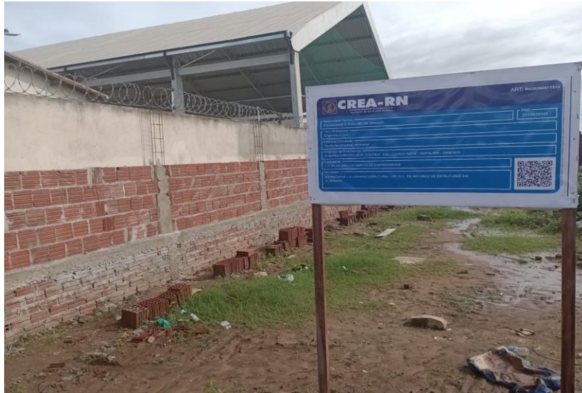
ALVENARIA E ESTRUTURA
