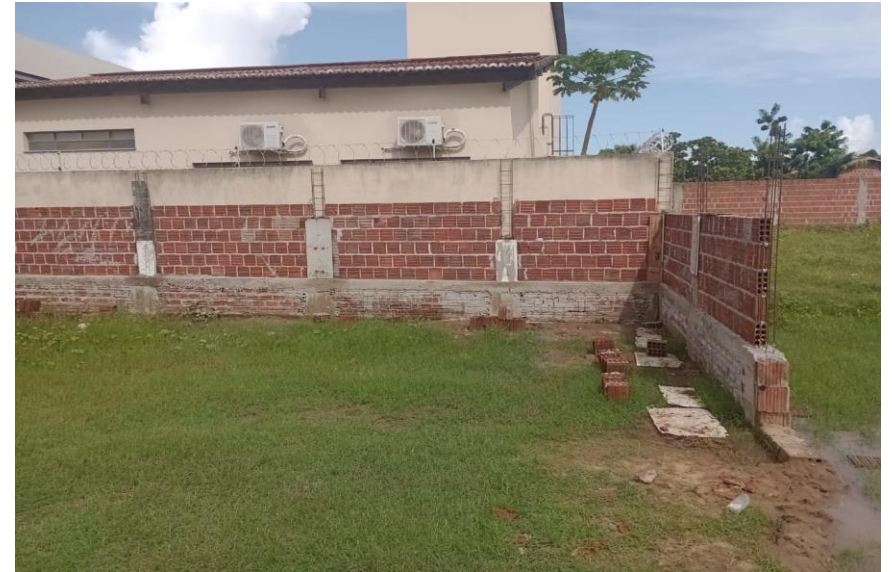
ALVENARIA E ESTRUTURA
