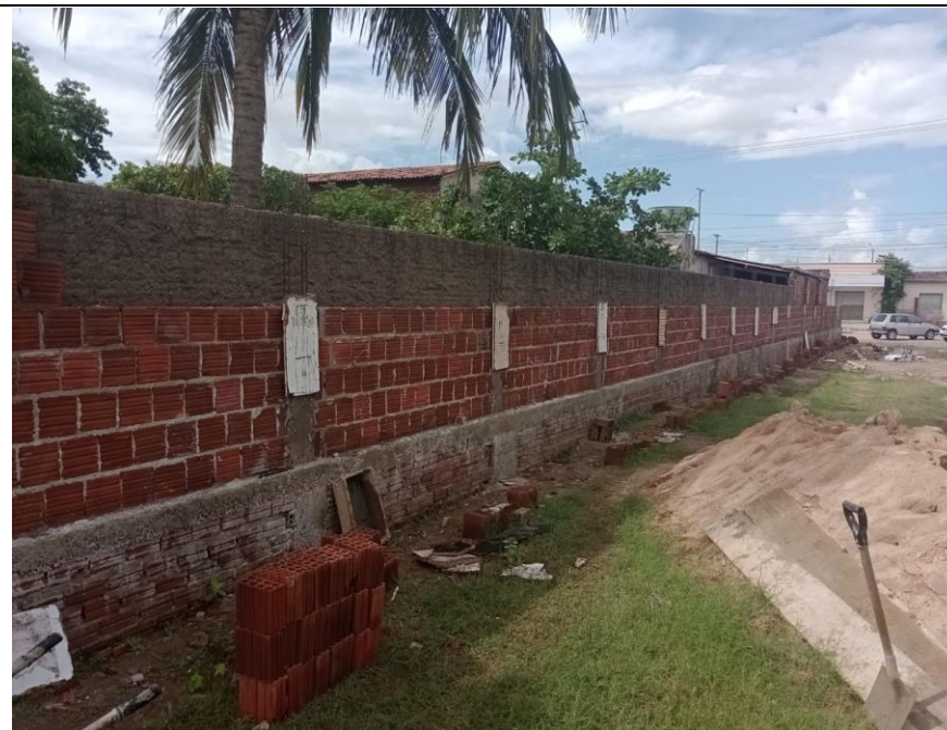
ALVENARIA E ESTRUTURA
